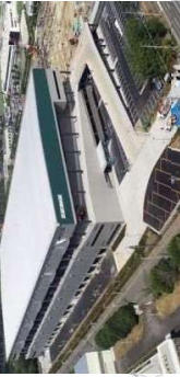
プロロジスパークつくば 操業：平成30年
