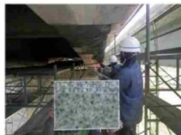
修繕の様子(断面修復)
