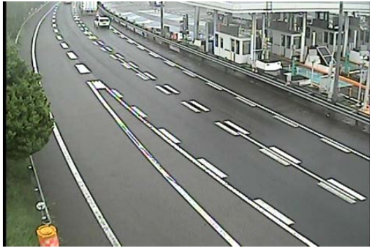
カメラ B (4.1kp 付近照明柱)
