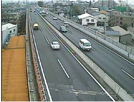
カメラ A (3.1kp 付近照明柱)
