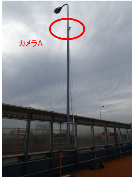
図 4-42 ビデオカメラの設置状況及び撮影アングル
