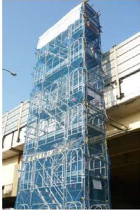
監視台①全景
