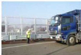
仮橋上部待機場所 (2台目) での車両確認状況
