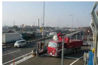
ノーズ部 (監視台②より) ・運転手用モニタ ・発進指示信号機 ・本線走行速度センサー ・速度LED表示板 ・ウェブカメラ②設置状況
