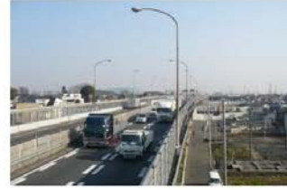
下流側本線状況
