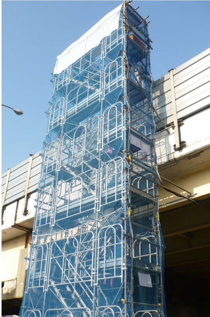
監視台①全景
