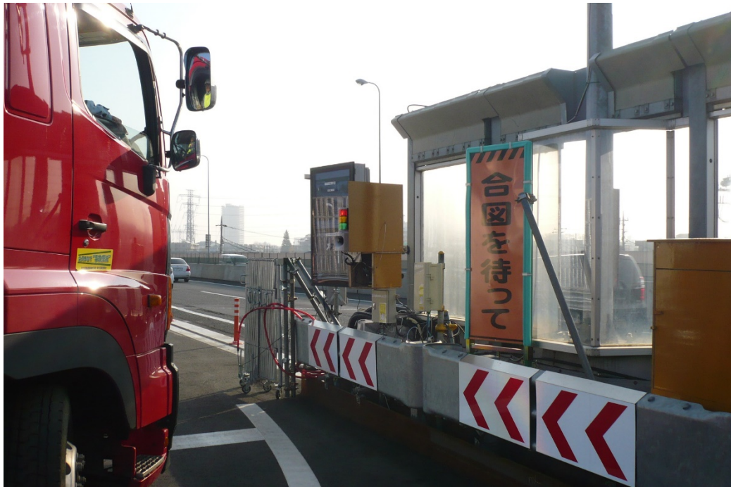
ノーズ部運転手向け設備 全景
