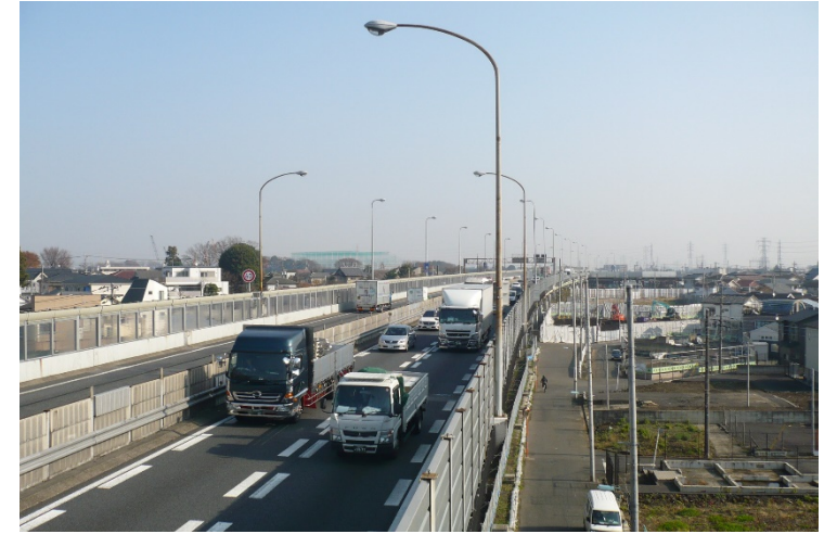
下流側本線状況
